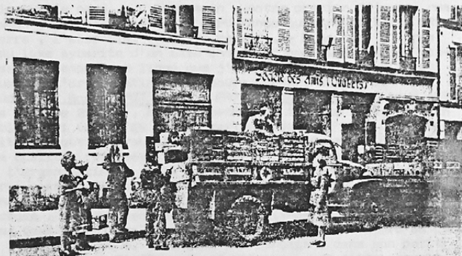
L'ancien Siège Social, 12, rue Guy-de-la-Brosse, Paris (5 e )
